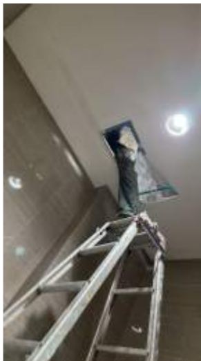
Gambar 4.2.17 perbaikan saluran floor drain mampet Sumber : foto pribadi
