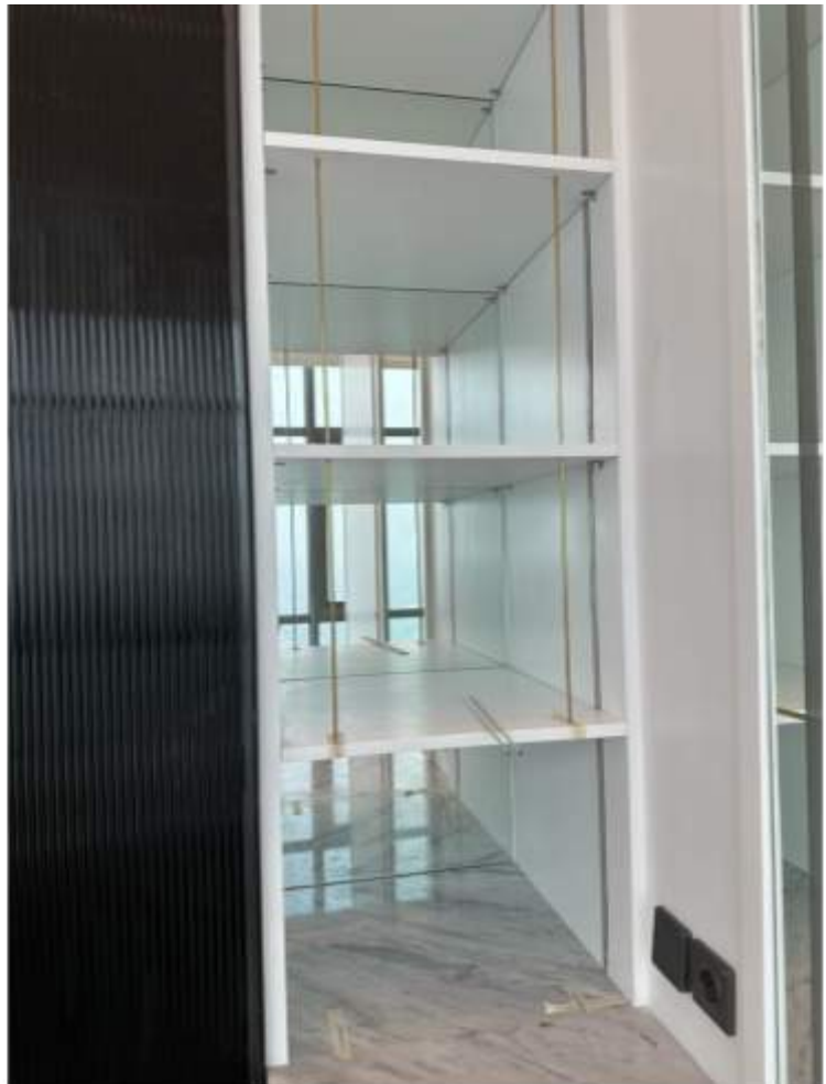
Gambar 4.2.22 pemasangan lis stainless Sumber : foto pribadi
