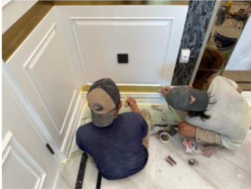
Gambar 4.2.7 perbaikan wall panel Sumber : foto pribadi
