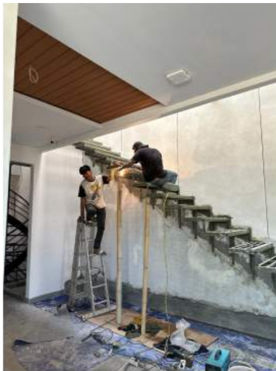
Gambar 4.2.28 pengelasan struktur tangga Sumber : foto pribadi
