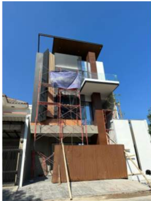
Gambar 4.2.29 pengecatan fasad Sumber : foto pribadi
