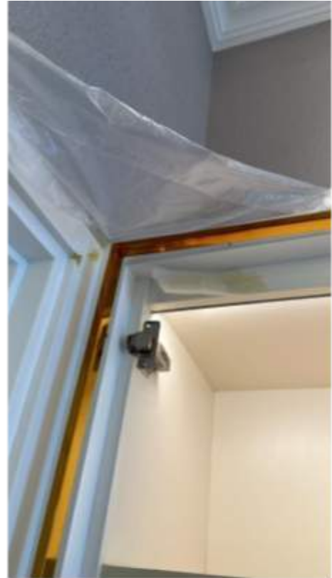
Gambar 4.2.24 cat stainless tidak rata Sumber : foto pribadi
