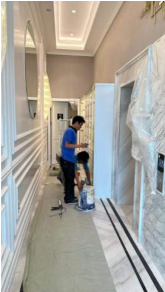
Gambar 4.2.21 pemasangan lis stainless Sumber : foto pribadi
