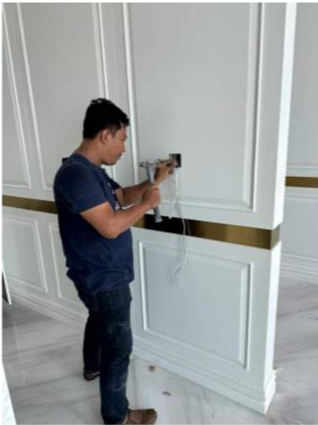
Gambar 4.2.19 penarikan kabel interkom Sumber : foto pribadi
