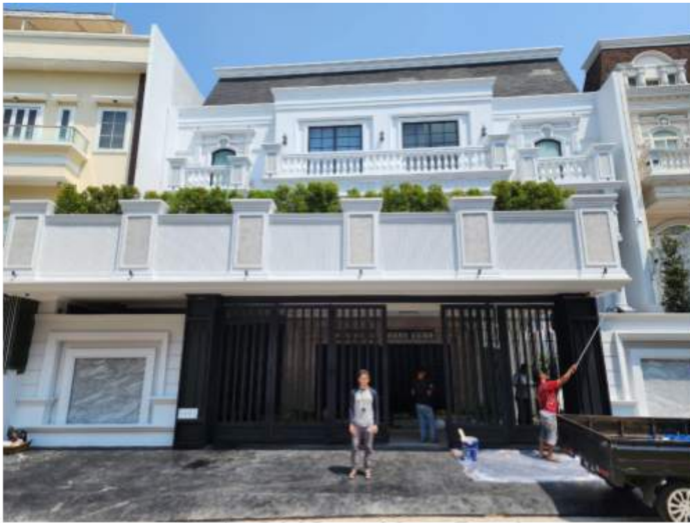
Gambar 3.1.4.3 proyek Layar Permai Sumber : foto pribadi
