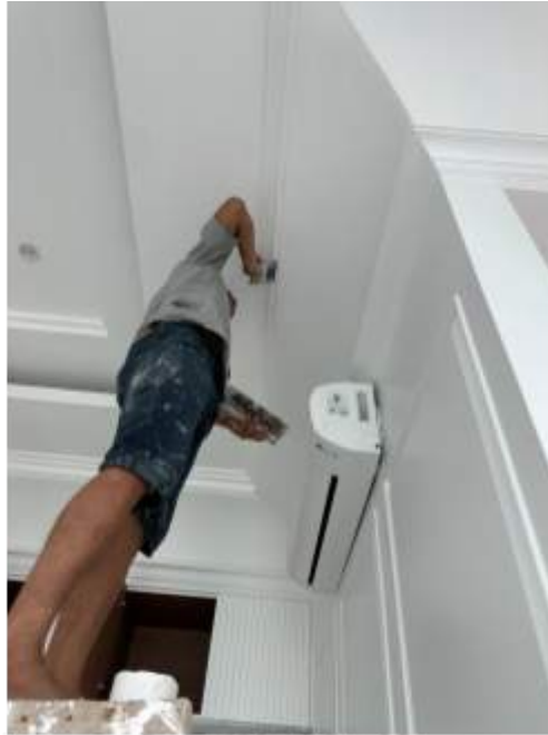
Gambar 4.2.2 perbaikan plafon Sumber : foto pribadi
