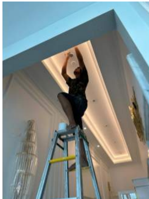
Gambar 4.2.3 perbaikan plafon Sumber : foto pribadi
