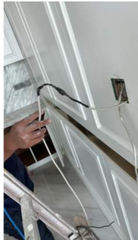
Gambar 4.2.20 penarikan kabel interkom Sumber : foto pribadi
