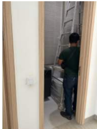
Gambar 4.2.18 perbaikan salur floor drain melalui unit bawah Sumber : foto pribadi
