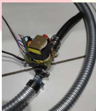
Gambar 5.33 Pemasangan Solenoid Valve
