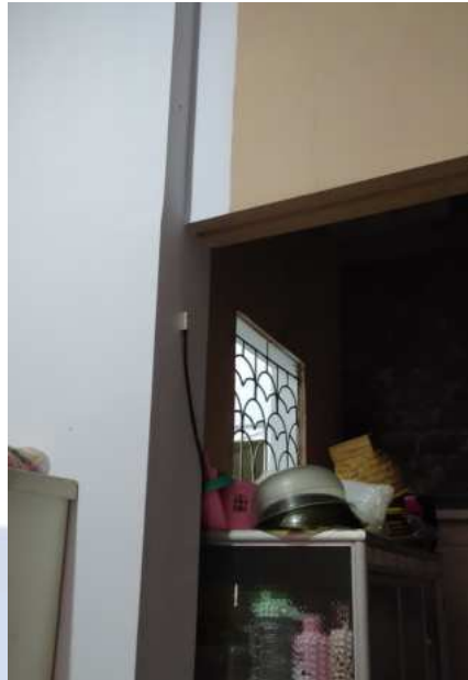
Gambar 5.40 Peletakkan Buzzer (Alarm) 2 Di Area Luar Dapur (Sumber : Dokumentasi Pribadi)
