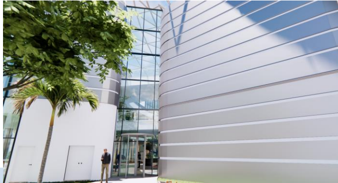
Gambar 5.57 Fasad dari bangunan Tera-Coast (Sumber: Analisis penulis, 2025)
