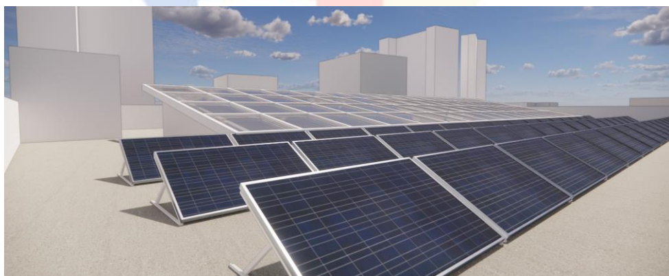
Gambar 2.1 Pemasangan Panel Surya
