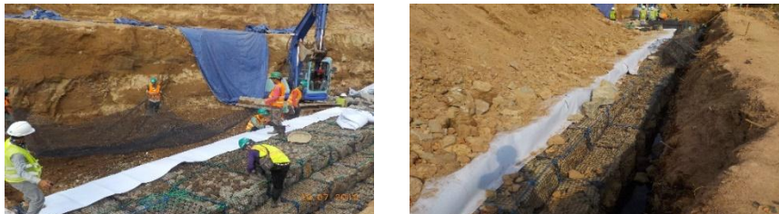
Gambar II.14 Geosintetik untuk Perkuatan Lereng
