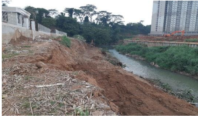
Gambar II.2 Kondisi Tanah Eksisting (Sumber: Dokumen Pribadi)
