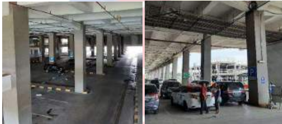
Gambar 4.46 Parkir Mobil di Terminal Terpadu Pulo Gebang Sumber: Dokumen Pribadi, 2020
