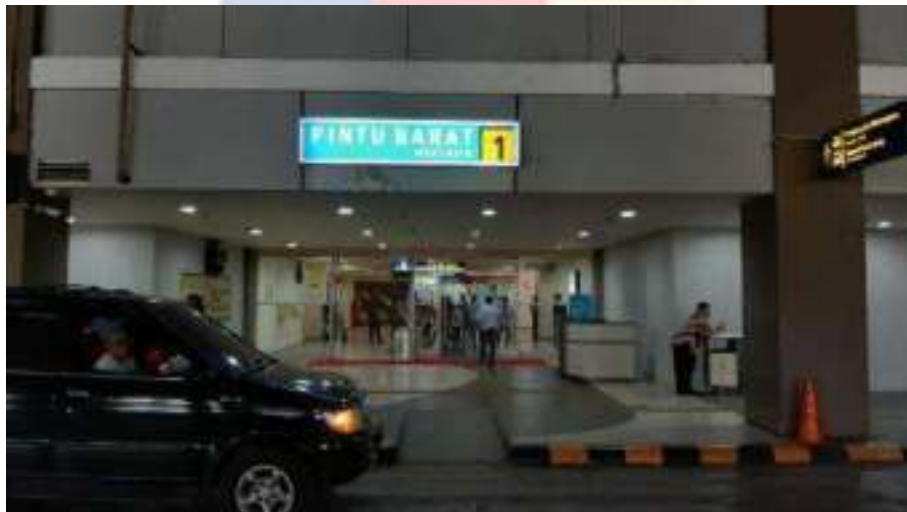
Gambar 4.48 Entrance Utama dari Parkir di Terminal Terpadu Pulo Gebang Sumber: Dokumen Pribadi, 2020
