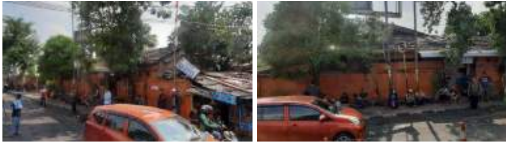
Gambar 4.25 Exit Area di Terminal Bus Kalideres Sumber: Dokumen Pribadi, 2020
