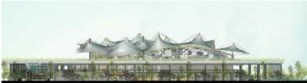
Gambar 5-31 Tampak Belakang (Utara) Terminal Bus Kalideres Sumber: Dokumen Pribadi, 2020
