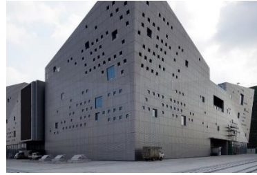
Gambar 2.1 eksterior bangunan Sumber: coordination.asia
