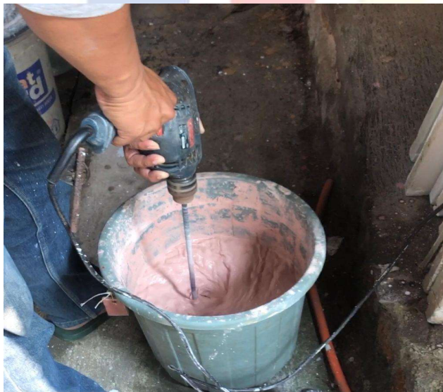
Gambar 4.39 Pengadukan Cat (Sumber : Dokumentasi Pribadi)
