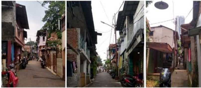
Gambar 1.3 Kondisi Bangunan Permanen dan Semi Permanen di RT 13-17 Sumber: Dokumentasi Survei, 2019
