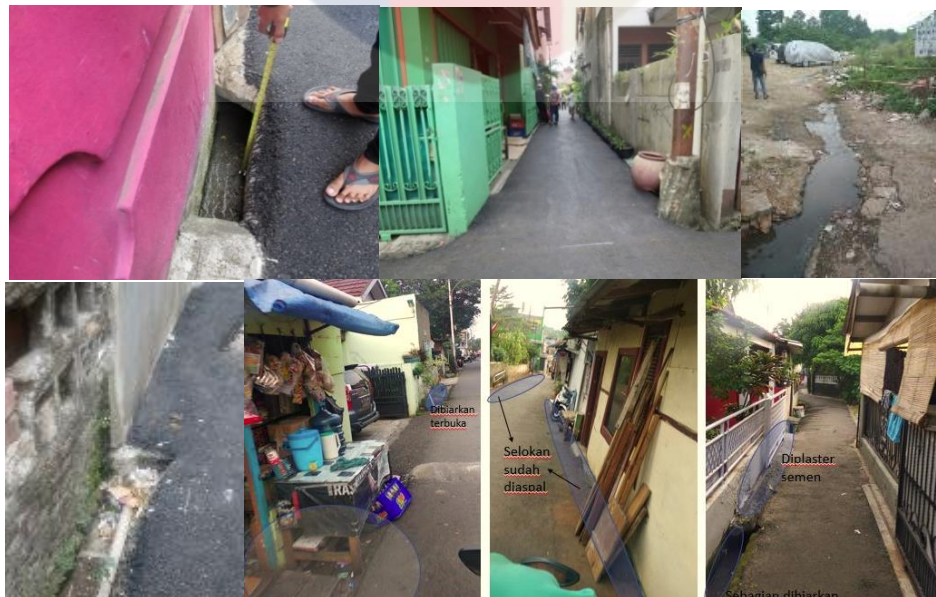
Gambar 1.6 Kondisi Drainase Eksisting di RW 5 Sumber : Dokumentasi Survei, 2019
