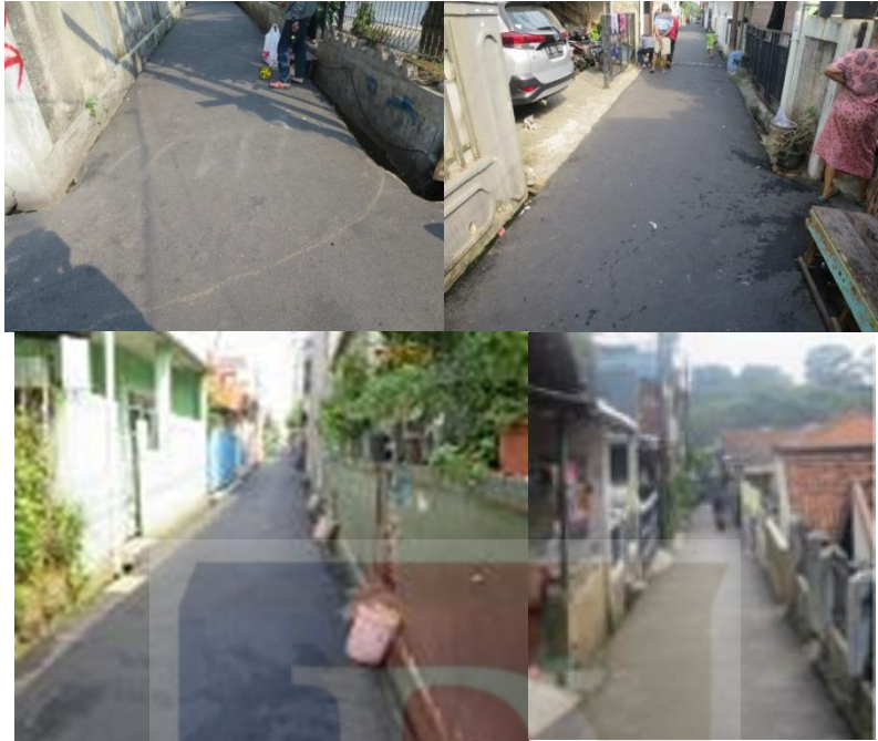
Gambar 1.5 Kondisi Jalan Eksisting di RW 5 Sumber : Dokumentasi Survei, 2019
