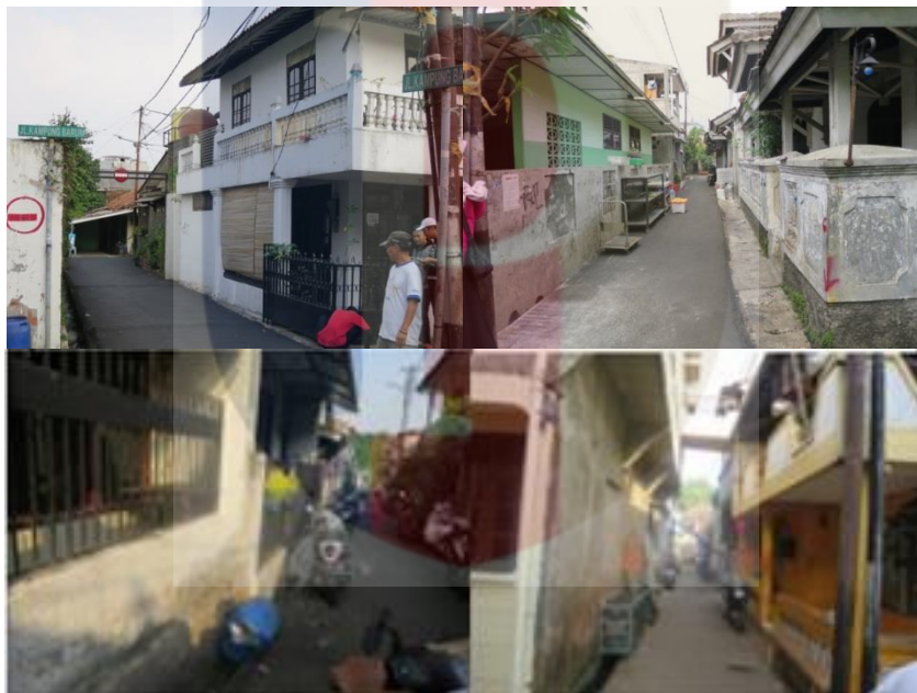
Gambar 1.4 Kondisi Lubang Ventilasi dan Jendela di RW 5 Sumber : Dokumentasi Survei, 2019
