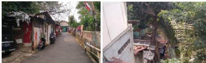
Gambar 1.2 Kondisi Bangunan Semi Permanen di Sempadan Kali Pesanggrahan RT 16 dan RT 3 Sumber: Dokumentasi Survei, 2019
