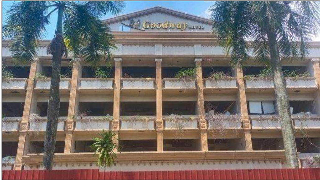
Gambar 4.37 Kondisi Gedung Hotel Goodway pada Bulan April 2021
