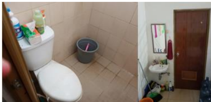
Gambar 53. Toilet Lt. 2 YCHI Autism Center Sumber: Dokumentasi Pribadi
