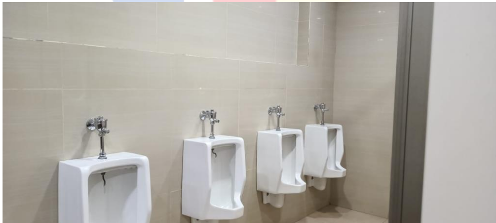
Gambar 4. 57. Foto Toilet Pria pada Gedung Grha Niaga Thamrin
