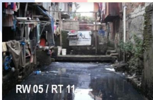
Gambar 23 Saluran Air yang Dijadikan WC (Sumber: Dinas Perumahan dan Gedung Pemda DKI Jakarta, 2013)
