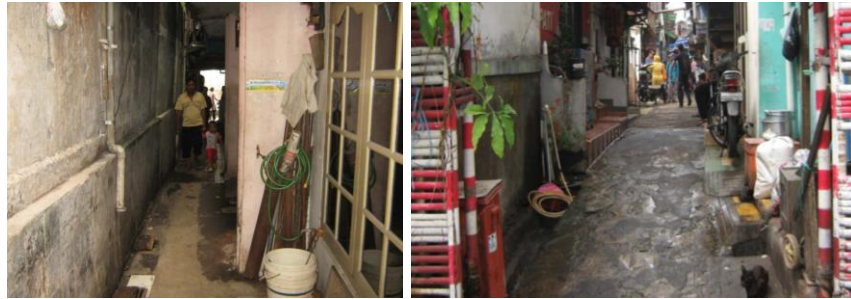
Gambar 18 Drainase Lingkungan Sebelum Perbaikan (Sumber: Dinas Perumahan dan Gedung Pemda DKI Jakarta, 2013)
