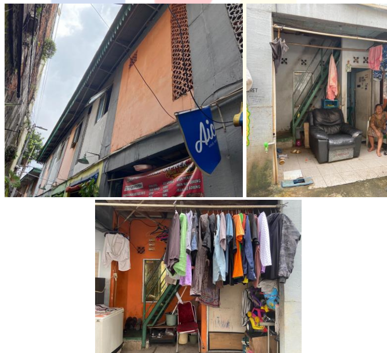
Gambar 11 Kualitas Bangunan Setelah Perbaikan (Sumber: Dokumentasi Pribadi, 2022)
