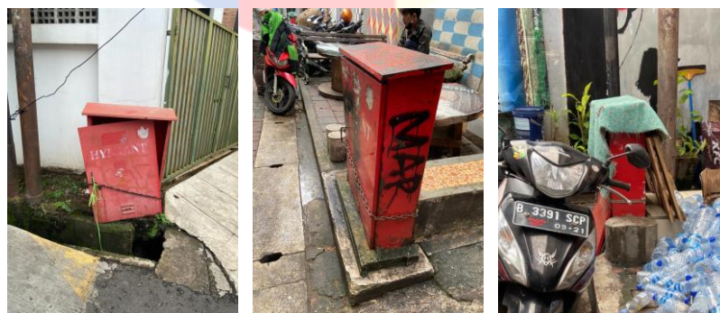
Gambar 30 Kondisi Hidran Setelah Perbaikan
