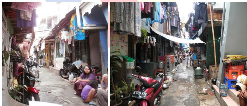
Gambar 12 Jaringan Jalan Sebelum Perbaikan (Sumber: Dinas Perumahan dan Gedung Pemda DKI Jakarta, 2013)
