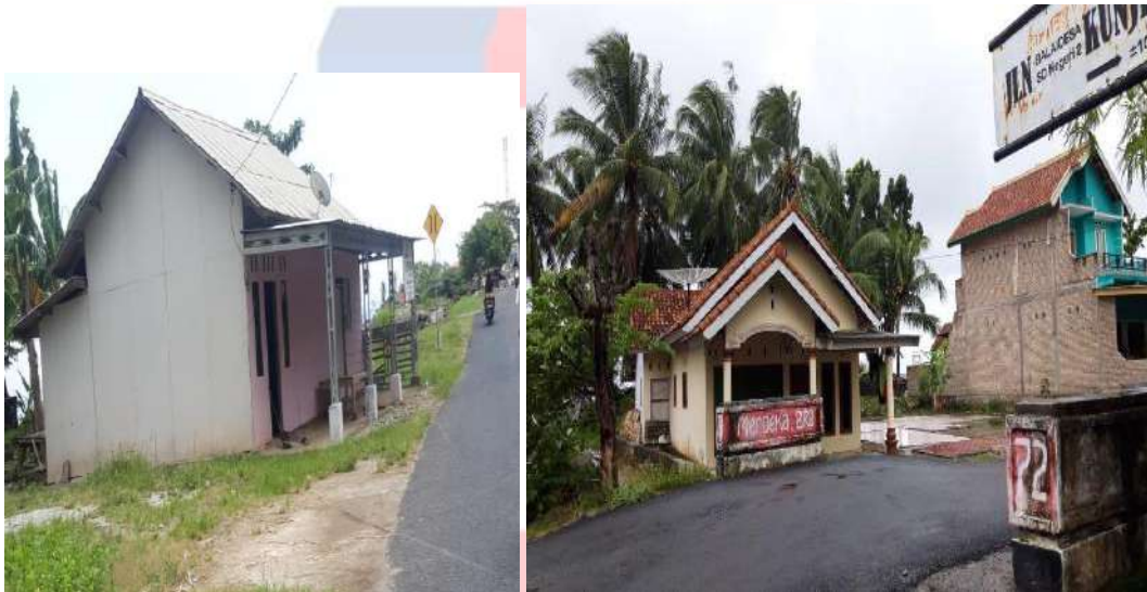
Gambar 6 (a) Bangunan Rumah Semi Permanen dan (b) Bangunan Permanen di Kecamatan Rajabasa
