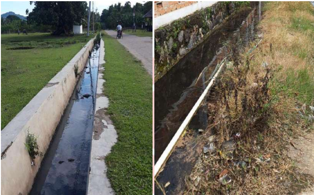
Gambar 21 Kondisi Jaringan Drainase di Kecamatan Rajabasa
