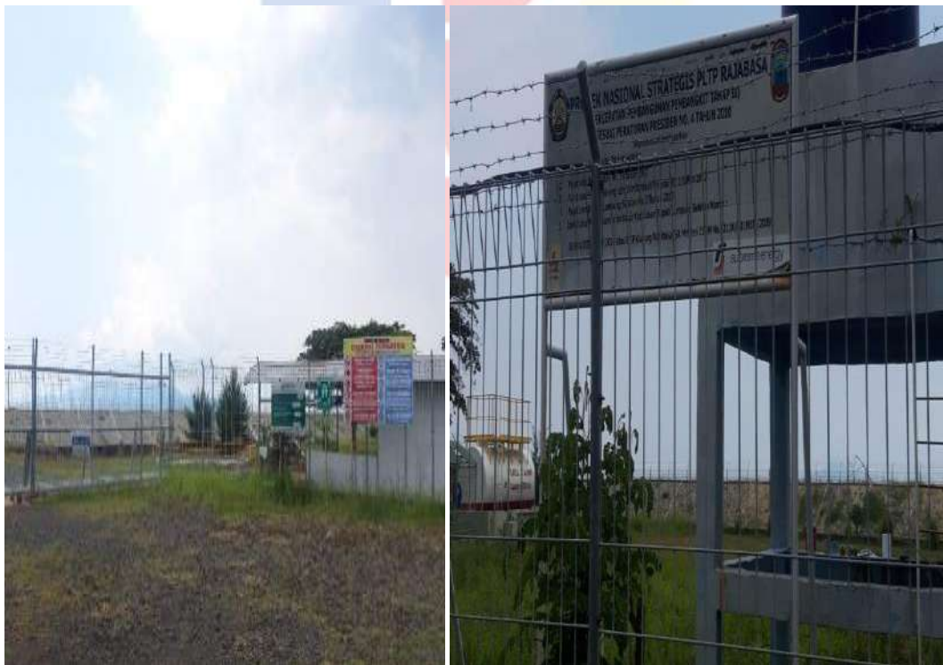
Gambar 19 Proyek Strategis Nasional PLTP (Pembangkit Listrik Tenaga Panas Bumi) di Desa Sukaraja, Kecamatan Rajabasa
