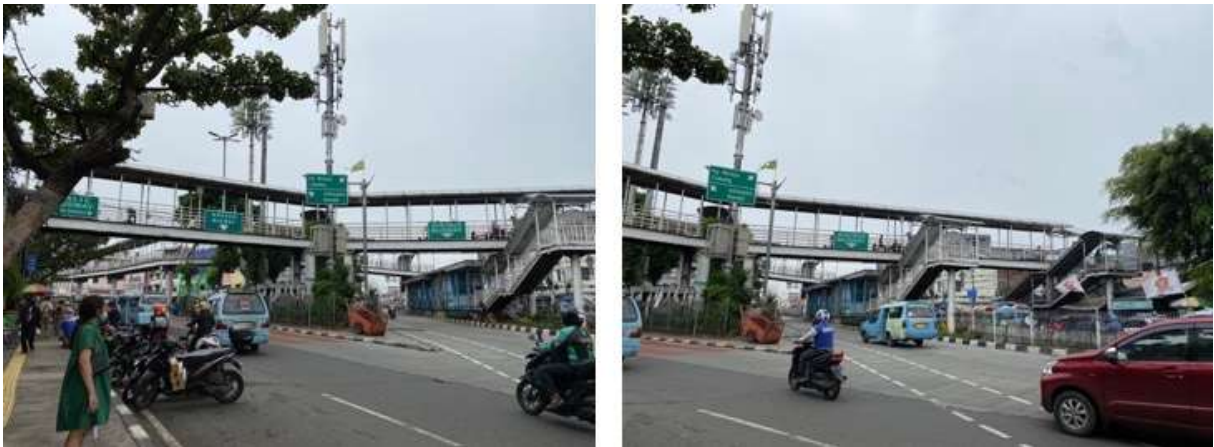
Gambar 4. 1 Kondisi Eksisting Halte TransJakarta
