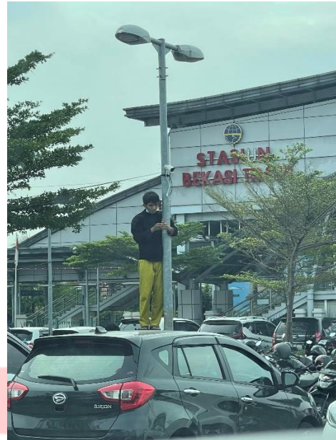
Pemasangan CCTV di area parkir
