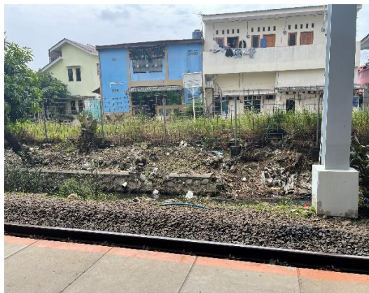
Kondisi drainase dan pembatas area stasiun dengan permukiman
