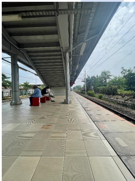
Kondisi Peron stasiun
