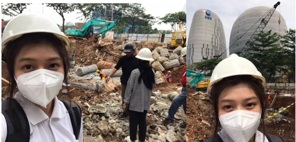
Gambar 5.4. Studi lapangan secara langsung ke proyek kantor JHL S8
