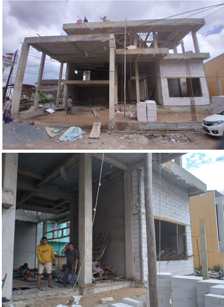
Gambar 4.2.3.2.1 Pengecekan Rumah Pak Ameng Melati Perdana Sumber: Pribadi
