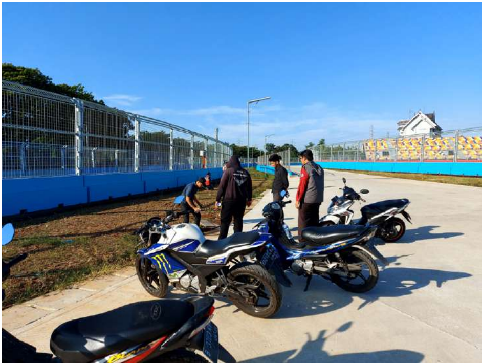
Gambar 4.4 Pengecekan Defect pada Sirkuit Formula-E
